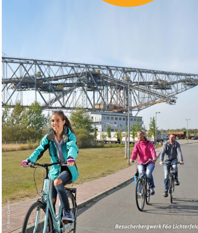
Besucherbergwerk F60 Lichterfeld
